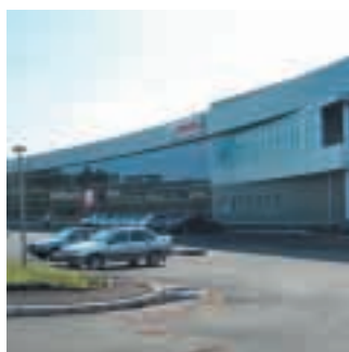
Тойота центр Внутренние работы по выравниванию полов ровнителями Р1, Р1 легкий, Р3 и облицовка плиткой клеем В.
