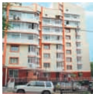
Жилой дом по ул. П. Комарова Внутренние работы. Выравнивание пола и облицовка плиткой. Продукция: ровнитель: Р1, ГР1, клей В.
