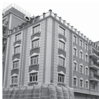
Элитный жилой дом на Исполкомской Работы велись внутри помещения по укладке керамической плитки и выравниванию полов материалами: В, Р1, Грунт1
