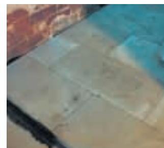
4 Укладывание плит из белого камня с клеем ПЛИТОНИТ-С
