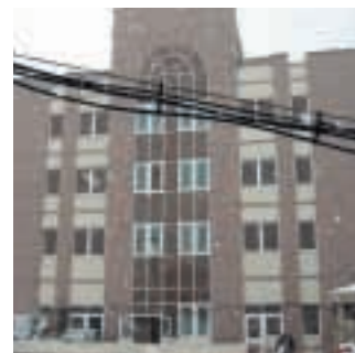
Онкоцентр – выравнивание полов; Гидроизоляция Тгидро
