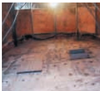
1 Нанесение гипсополимерной стяжки ровнителем ПЛИТОНИТ-ГР1
