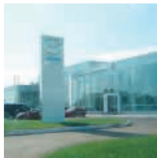
Автоцентр Форд и Mazda Внутренние работы: выравнивание полов ровнителями Р1, Р3 и облицовка плиткой клеем В
