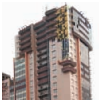
Жилой комплекс Золотая Гавань Велись внутренние работы материалами: клеем А и В; Грунт 1; шпаклевками К и Кф
