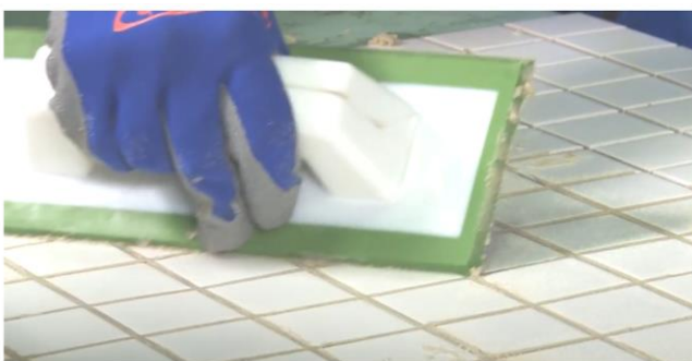
Рис. 22. Диагональными движениями шпателя убрать с поверхности плитки излишки затирки
