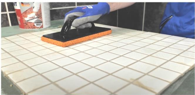
Рис. 23. Диагональными движениями шпателя убрать с поверхности плитки излишки затирки
