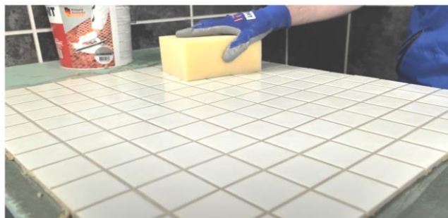
Рис. 23. Диагональными движениями шпателя убрать с поверхности плитки излишки затирки
