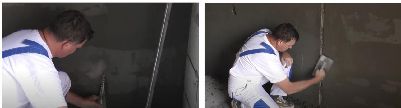
Рис. 26. Схема демонтажа маяков и заделки образовавшихся борозд
