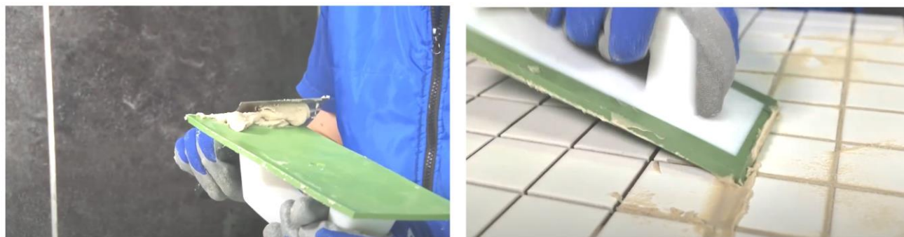
Рис. 36. Заполнение швов затиркой при помощи резинового шпателя
