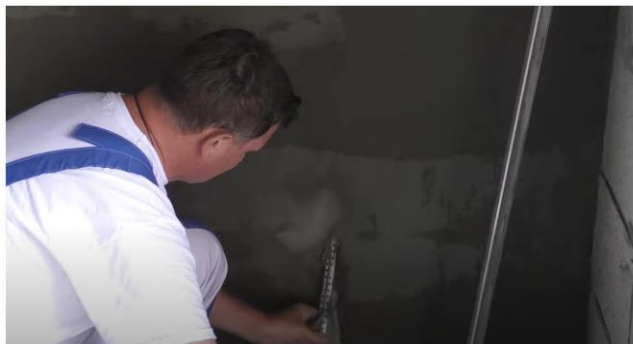
Рис. 18. Схема демонтажа маяков и заделки образовавшихся борозд
