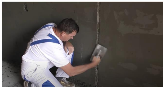
Рис. 18. Схема демонтажа маяков и заделки образовавшихся борозд
