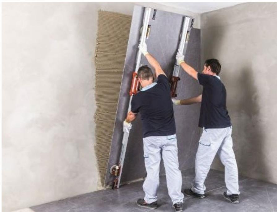
Рис. 6. Монтаж керамогранита
