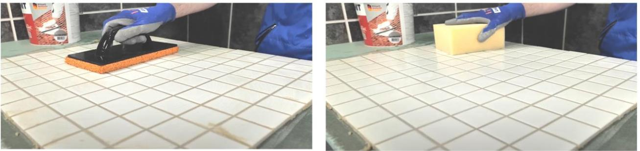
Рис. 32. Диагональными движениями шпателя убрать с поверхности плитки излишки затирки
