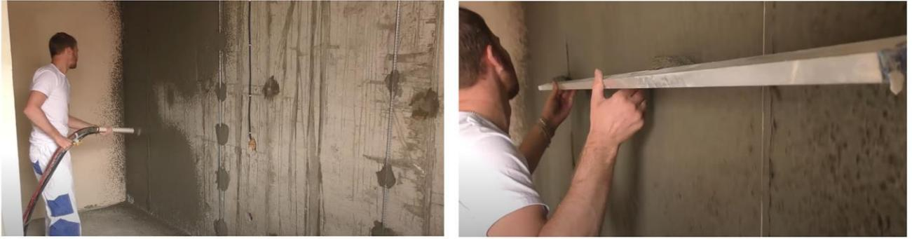
Рис. 21. Схема нанесения обрызга на поверхность и разравнивание правилами образовавшихся напылов
