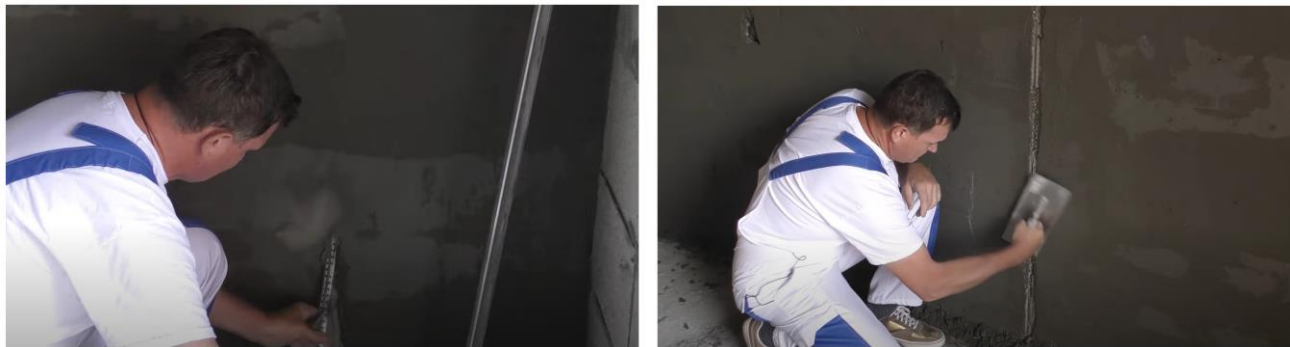
Рис. 24. Схема демонтажа маяков и заделки образовавшихся борозд
