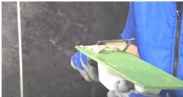
Рис. 25. Заполнение швов затиркой при помощи резинового шпателя
