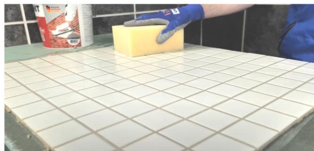
Поверхность, затертую эпоксидной затиркой, замыть сразу же после нанесения при помощи хорошо отжатой целлюлозной губки PLITONIT (см. Рис. 28). Если на поверхности осталось много эпоксидного материала, то удаляем его абразивным слоем (см. Рис. 28, слева). Если же нет – сразу используем мягкую губку (см. Рис. 28 справа). Производитель рекомендует работать с минимальным нажимом и часто промывать губку в ёмкости с чистой водой.
