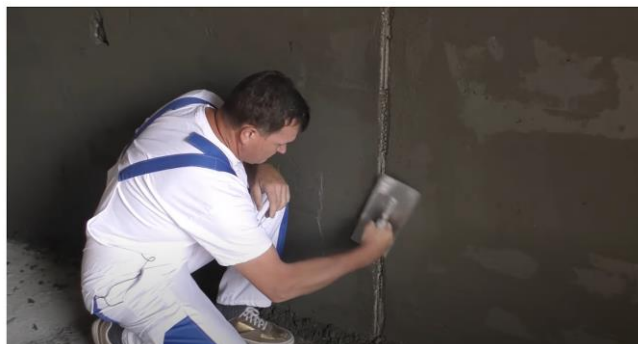
Рис. 18. Схема демонтажа маяков и заделки образовавшихся борозд
