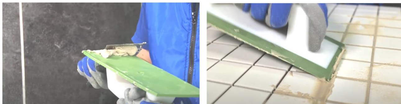
Рис. 23. Заполнение швов затиркой при помощи резинового шпателя
