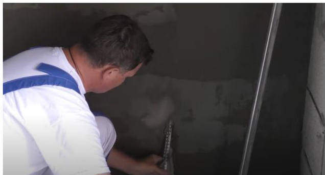
Рис. 18. Схема демонтажа маяков и заделки образовавшихся борозд
