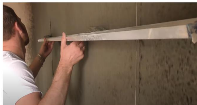
Рис. 20. Схема нанесения обрызга на поверхность и разравнивание правилами образовавшихся наплывов
