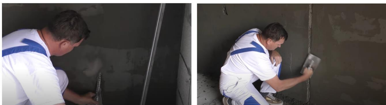
Рис. 26. Схема демонтажа маяков и заделки образовавшихся борозд
