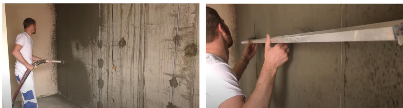
Рис. 24. Схема нанесения обрызга на поверхность и разравнивание правилами образовавшихся наплывов
