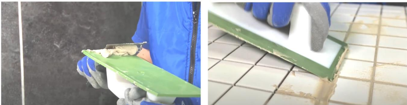
Рис. 23. Заполнение швов затиркой при помощи резинового шпателя
