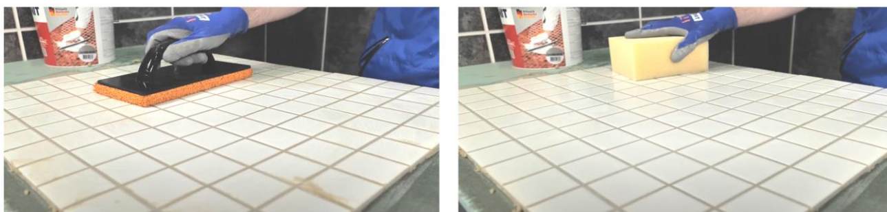
Рис. 33. Диагональными движениями шпателя убрать с поверхности плитки излишки затирки
