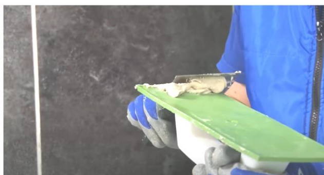
Рис. 5. Заполнение швов эпоксидной затиркой при помощи резинового шпателя
