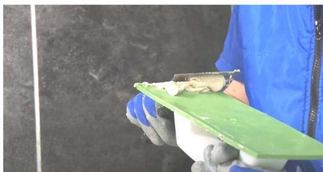
Рис. 5. Заполнение швов эпоксидной затиркой при помощи резинового шпателя
