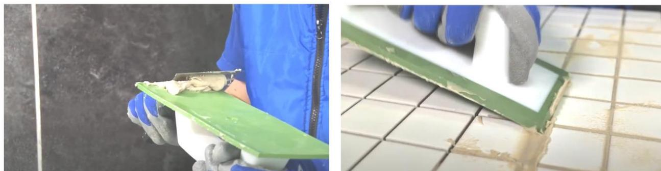
Рис. 22. Заполнение швов затиркой при помощи резинового шпателя
