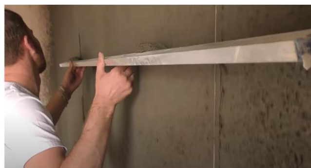
Излишки раствора сбрасывают в подборники. При разравнивании слоя грунта один из штукатуров (ШЗ) перемещает полутерок снизу-вверх зигзагообразными движениями вправо и
