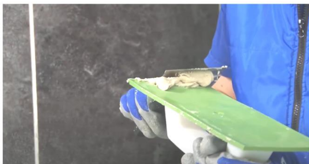
Рис. 29. Заполнение швов затиркой при помощи резинового шпателя
