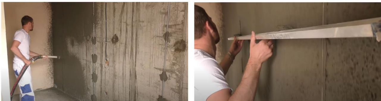
Рис. 22. Схема нанесения обрызга на поверхность и разравнивание правилами образовавшихся наплывов
