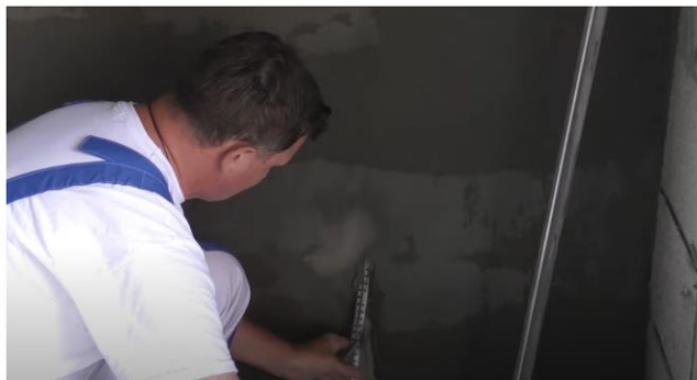
Рис. 24. Схема демонтажа маяков и заделки образовавшихся борозд
