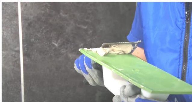
Рис. 27. Заполнение швов затиркой при помощи резинового шпателя
