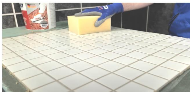
Рис. 29. Диагональными движениями шпателя убрать с поверхности плитки излишки затирки
