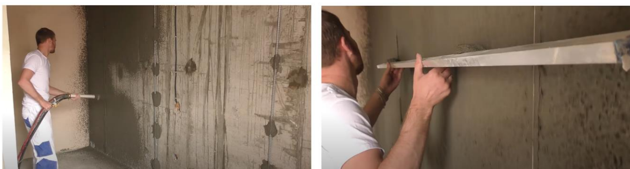
Рис. 18. Схема нанесения обрызга на поверхность и разравнивание правилами образовавшихся наплывов
