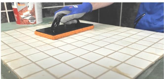
Рис. 29. Диагональными движениями шпателя убрать с поверхности плитки излишки затирки
