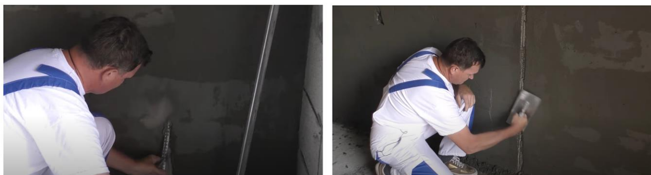
Рис. 27. Схема демонтажа маяков и заделки образовавшихся борозд
