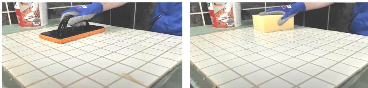
Рис. 42. Диагональными движениями шпателя убрать с поверхности плитки излишки затирки
