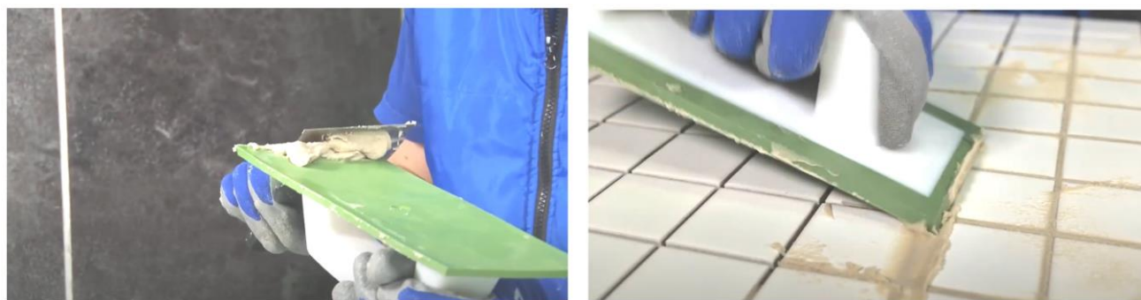
Рис. 40. Заполнение швов затиркой при помощи резинового шпателя
