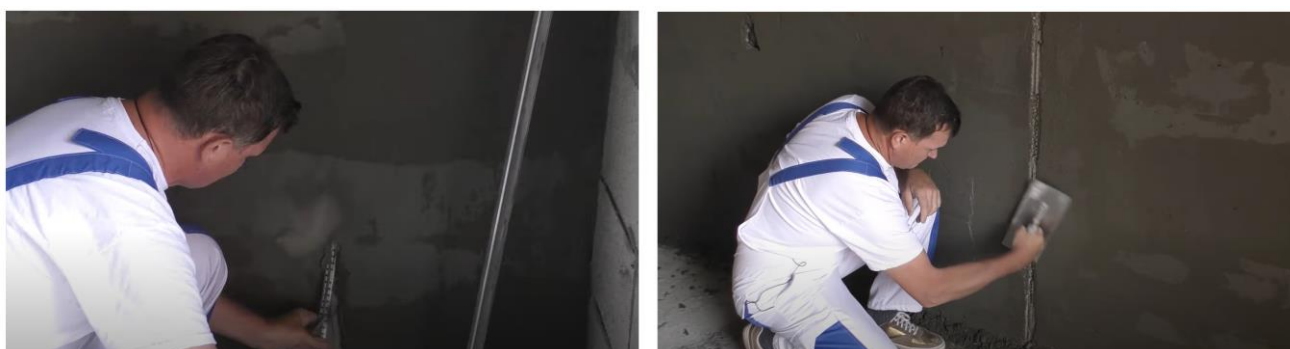
Рис. 23. Схема демонтажа маяков и заделки образовавшихся борозд
