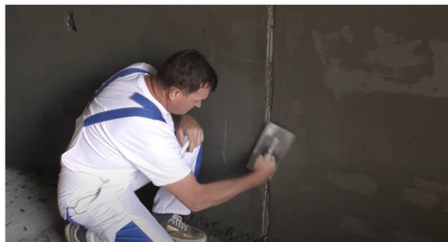
Рис. 16. Схема демонтажа маяков и заделки образовавшихся борозд
