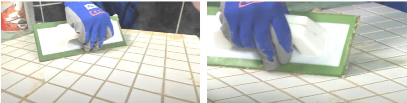
Рис. 13. Диагональными движениями шпателя убрать с поверхности плитки излишки затирки
