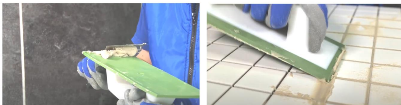
Рис. 12. Заполнение швов затиркой при помощи резинового шпателя
