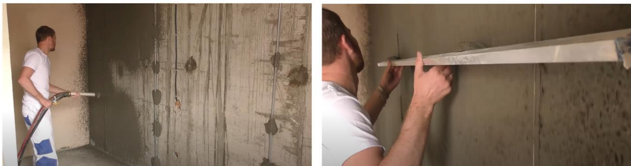
Рис. 20. Схема нанесения обрызга на поверхность и разравнивание правилами образовавшихся наплывов
