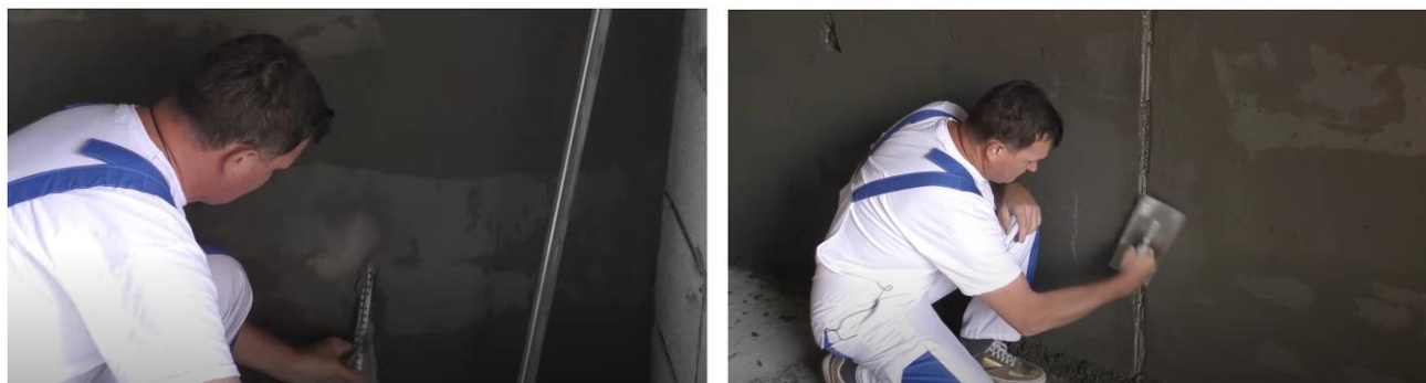
Рис. 22. Схема демонтажа маяков и заделки образовавшихся борозд
