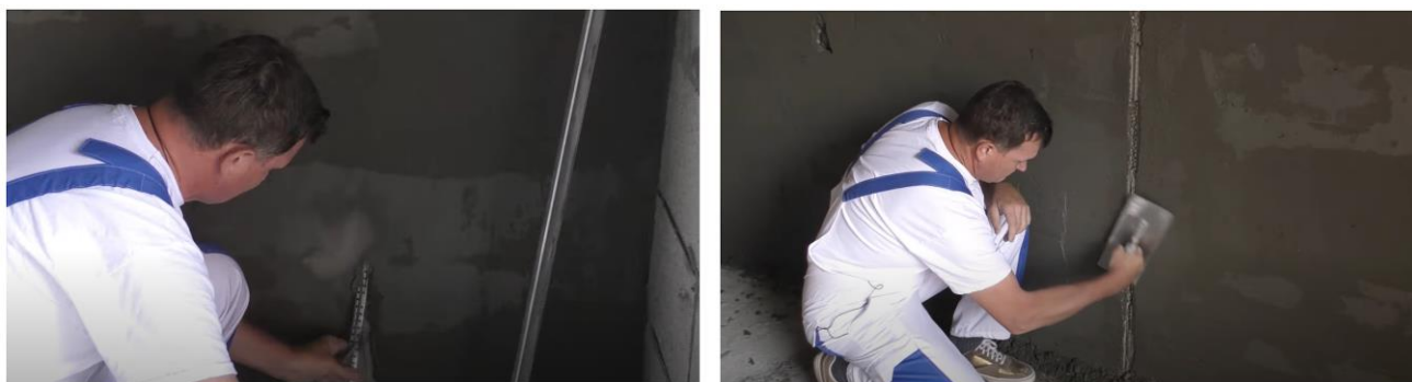
Рис. 30. Схема демонтажа маяков и заделки образовавшихся борозд
