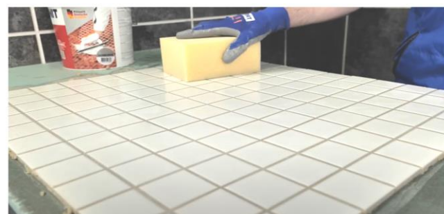
Рис. 38. Диагональными движениями шпателя убрать с поверхности плитки излишки затирки
