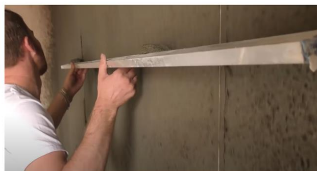
Рис. 19. Схема нанесения обрызга на поверхность и разравнивание правилами образовавшихся наплывов
