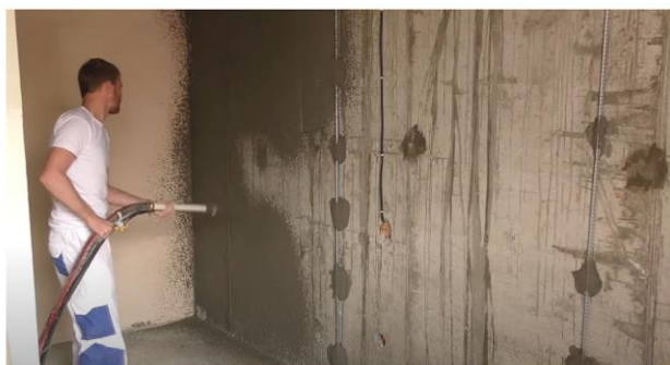
Рис. 19. Схема нанесения обрызга на поверхность и разравнивание правилами образовавшихся наплывов
