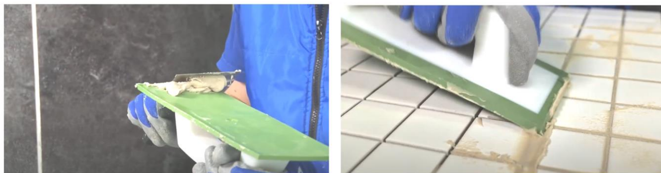
Рис. 39. Заполнение швов затиркой при помощи резинового шпателя
