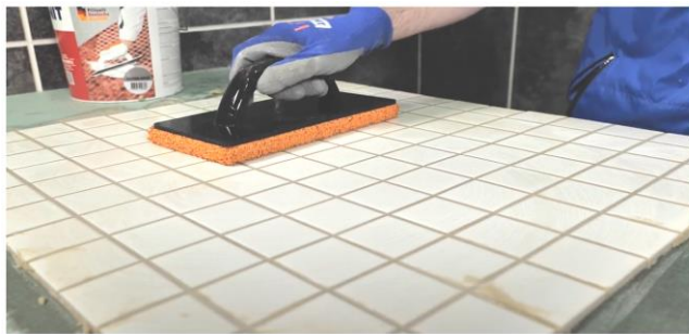
Рис. 21. Диагональными движениями шпателя убрать с поверхности плитки излишки затирки
