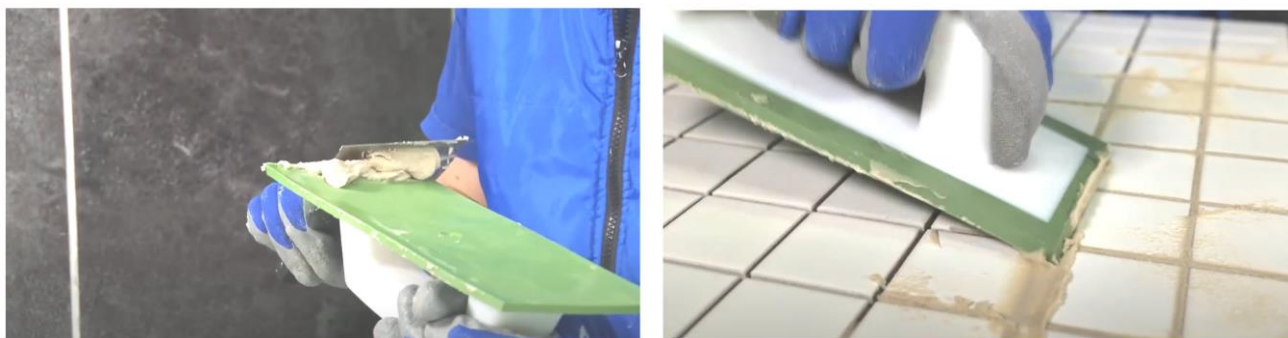
Рис. 19. Заполнение швов затиркой при помощи резинового шпателя
