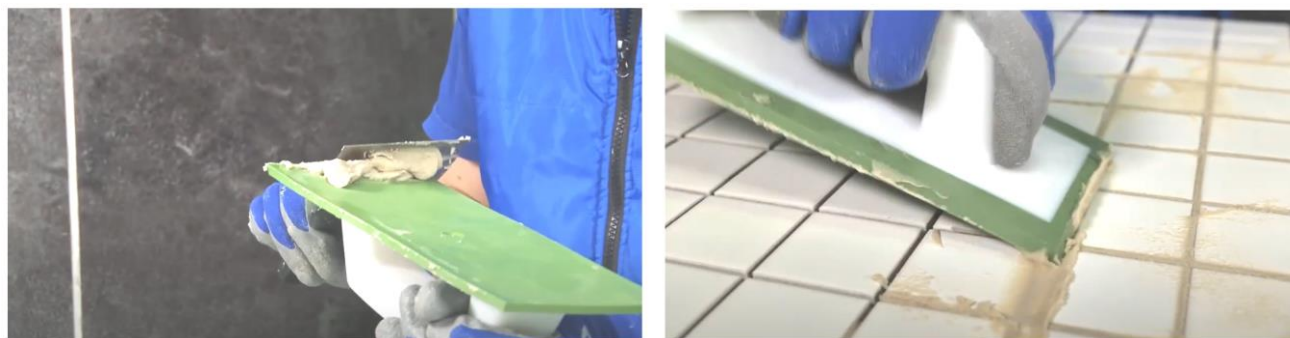
Рис. 32. Заполнение швов затиркой при помощи резинового шпателя
