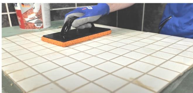
Рис. 34. Диагональными движениями шпателя убрать с поверхности плитки излишки затирки
