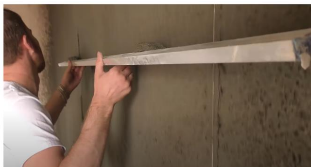
Рис. 22. Схема нанесения обрызга на поверхность и разравнивание правилами образовавшихся наплывов
