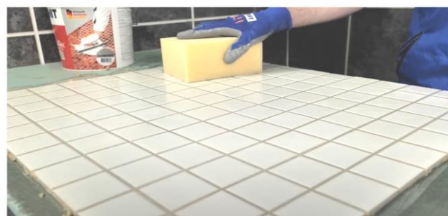
Рис. 34. Диагональными движениями шпателя убрать с поверхности плитки излишки затирки
