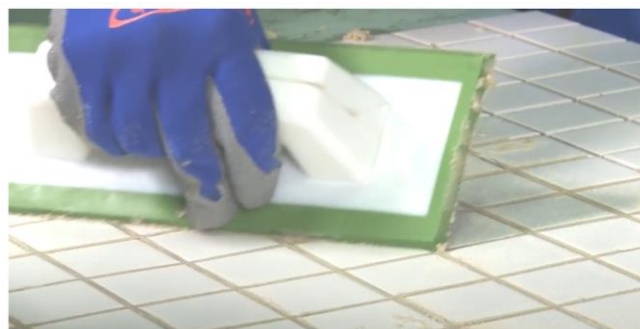
Рис. 33. Диагональными движениями шпателя убрать с поверхности плитки излишки затирки
