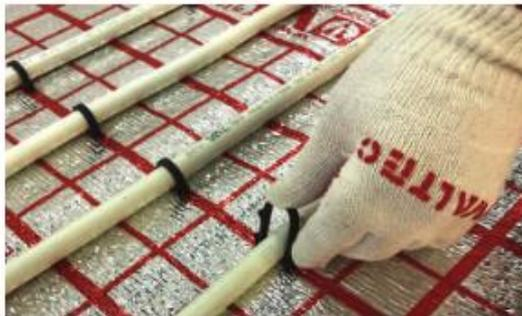
Рис.20. Крепление труб к сетке пластиковыми гарпунными скобами.
