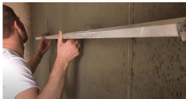
Рис. 25. Схема нанесения обрызга на поверхность и разравнивание правилами образовавшихся наплывов
