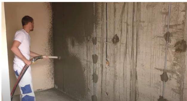
Рис. 25. Схема нанесения обрызга на поверхность и разравнивание правилами образовавшихся наплывов
