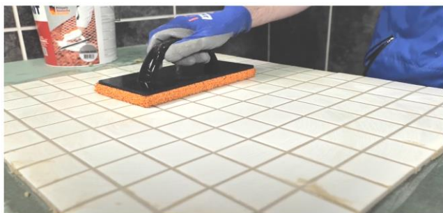
Рис. 36. Диагональными движениями шпателя убрать с поверхности плитки излишки затирки
