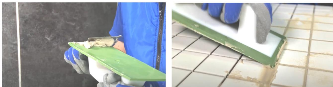
Рис. 34. Заполнение швов затиркой при помощи резинового шпателя
