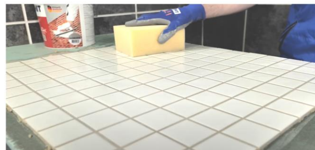
Рис. 36. Диагональными движениями шпателя убрать с поверхности плитки излишки затирки
