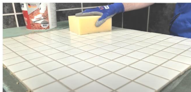
Рис. 33. Диагональными движениями шпателя убрать с поверхности плитки излишки затирки
