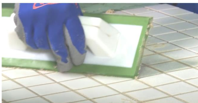
Рис. 32. Диагональными движениями шпателя убрать с поверхности плитки излишки затирки
