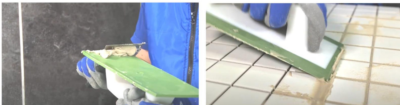
Рис. 30. Заполнение швов затиркой при помощи резинового шпателя
