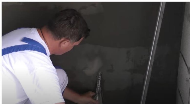
Рис. 25. Схема демонтажа маяков и заделки образовавшихся борозд
