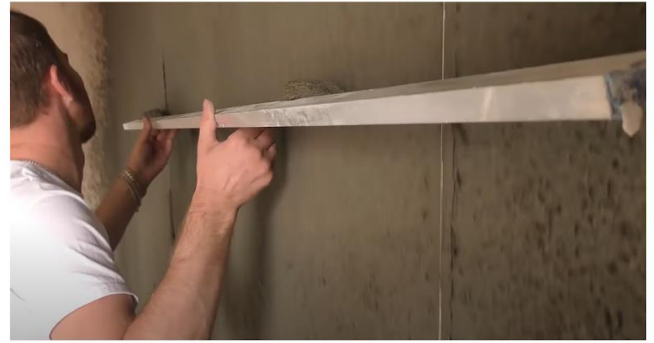
Рис. 23. Схема нанесения обрызга на поверхность и разравнивание правилами образовавшихся наплывов
