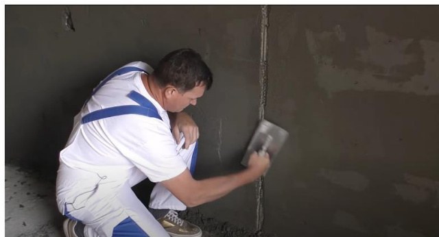
Рис. 25. Схема демонтажа маяков и заделки образовавшихся борозд
