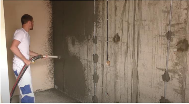
Рис. 23. Схема нанесения обрызга на поверхность и разравнивание правилами образовавшихся наплывов
