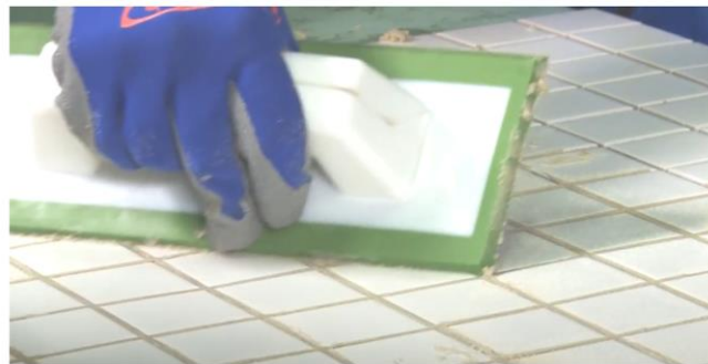
Рис. 30. Диагональными движениями шпателя убрать с поверхности плитки излишки затирки
