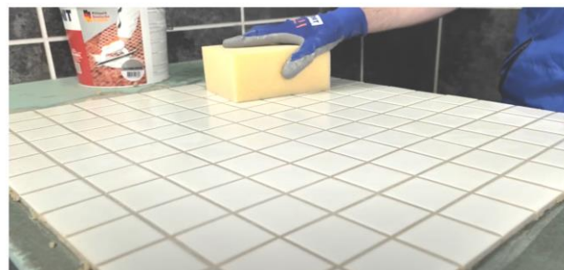
Рис. 31. Диагональными движениями шпателя убрать с поверхности плитки излишки затирки
