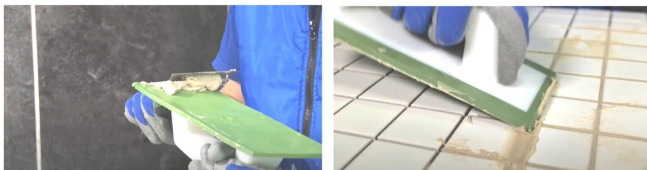
Рис. 29. Заполнение швов затиркой при помощи резинового шпателя
