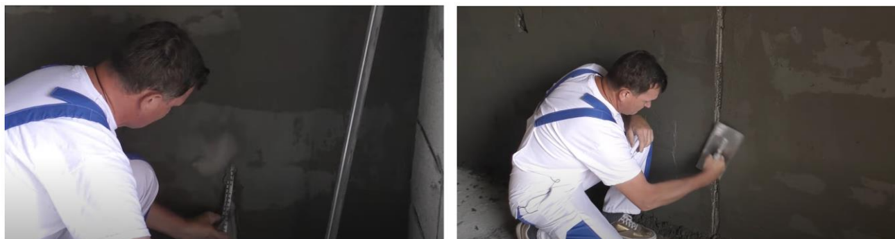
Рис. 26. Схема демонтажа маяков и заделки образовавшихся борозд
