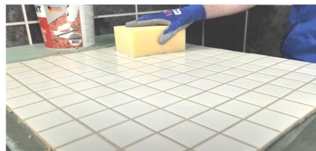
Рис. 37. Диагональными движениями шпателя убрать с поверхности плитки излишки затирки
