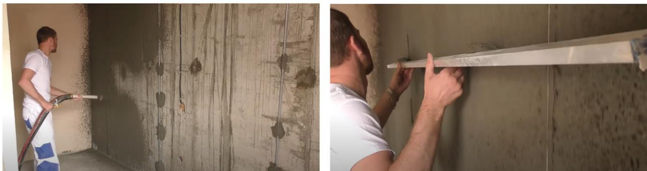
Рис. 24. Схема нанесения обрызга на поверхность и разравнивание правилами образовавшихся наплывов
