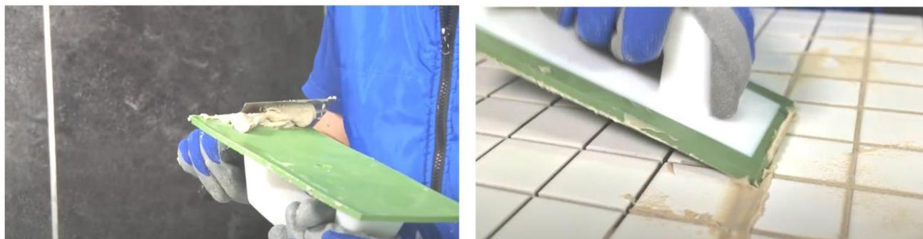
Рис. 28. Заполнение швов затиркой при помощи резинового шпателя
