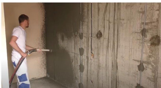
Рис. 26. Схема нанесения обрызга на поверхность и разравнивание правилами образовавшихся наплывов
