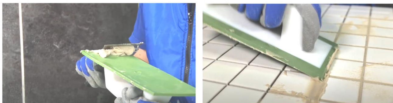
Рис. 41. Заполнение швов затиркой при помощи резинового шпателя
