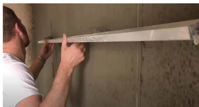
Рис. 26. Схема нанесения обрызга на поверхность и разравнивание правилами образовавшихся наплывов
