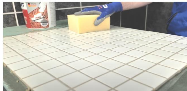
Рис. 42. Диагональными движениями шпателя убрать с поверхности плитки излишки затирки
