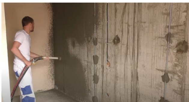
Рис. 21. Схема нанесения обрызга на поверхность и разравнивание правилами образовавшихся наплывов
