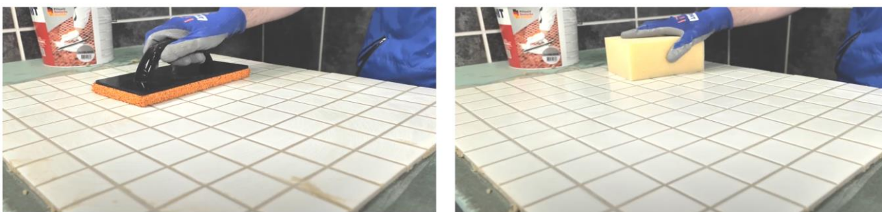
Рис. 22. Диагональными движениями шпателя убрать с поверхности плитки излишки затирки
