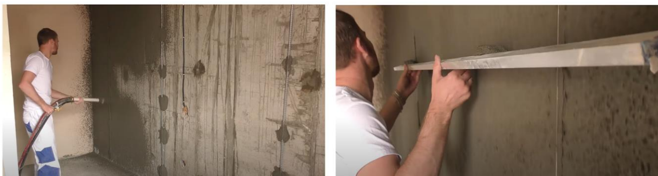
Рис. 19. Схема нанесения обрызга на поверхность и разравнивание правилами образовавшихся наплывов
