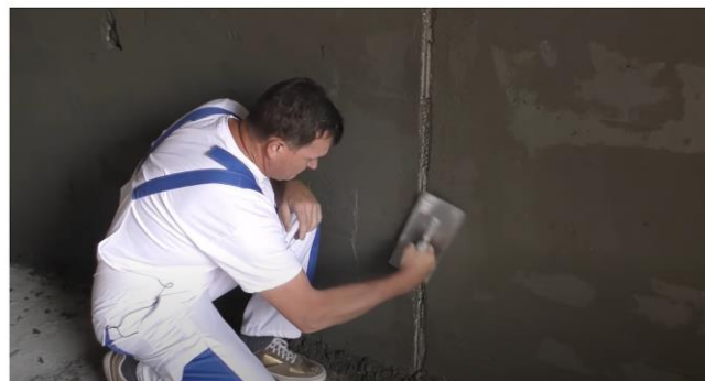
Рис. 16. Схема демонтажа маяков и заделки образовавшихся борозд
