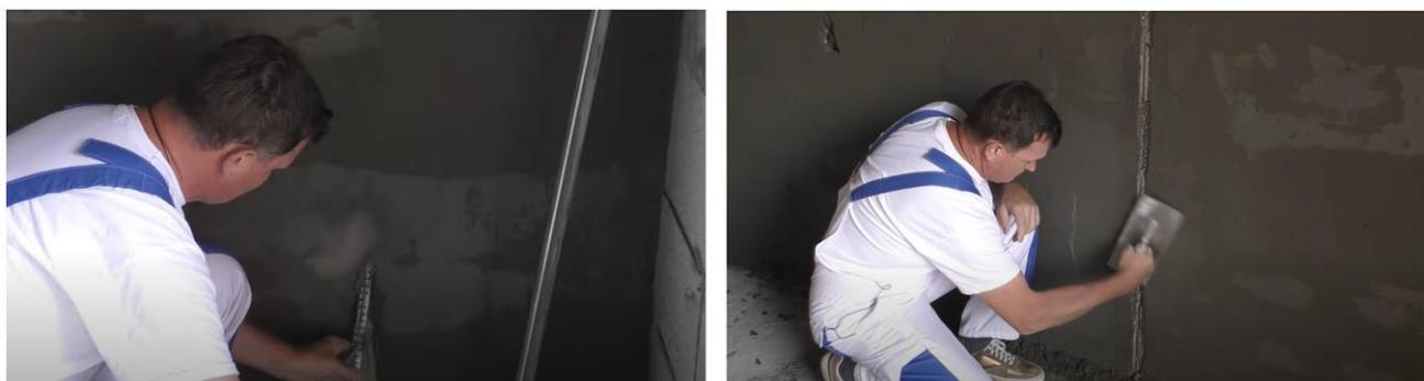
Рис. 21. Схема демонтажа маяков и заделки образовавшихся борозд
