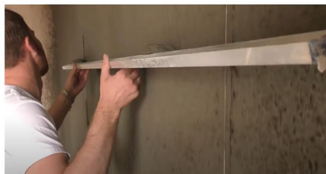
Рис. 27. Схема нанесения обрызга на поверхность и разравнивание правилами образовавшихся наплывов
