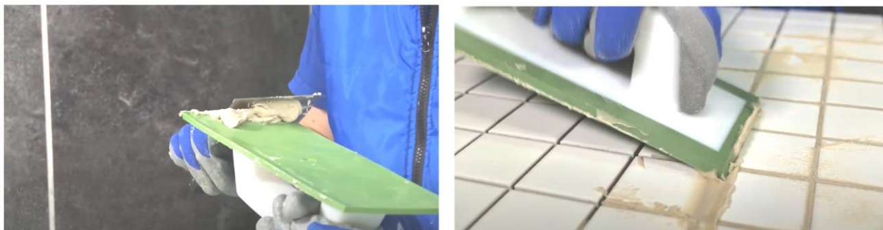
Рис. 36. Заполнение швов затиркой при помощи резинового шпателя
