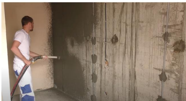
Рис. 27. Схема нанесения обрызга на поверхность и разравнивание правилами образовавшихся наплывов
