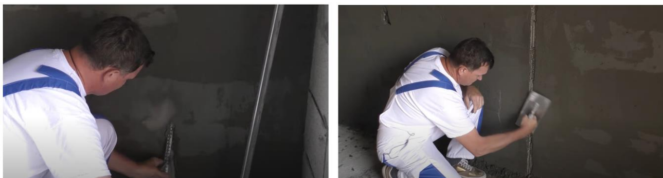
Рис. 21. Схема демонтажа маяков и заделки образовавшихся борозд
