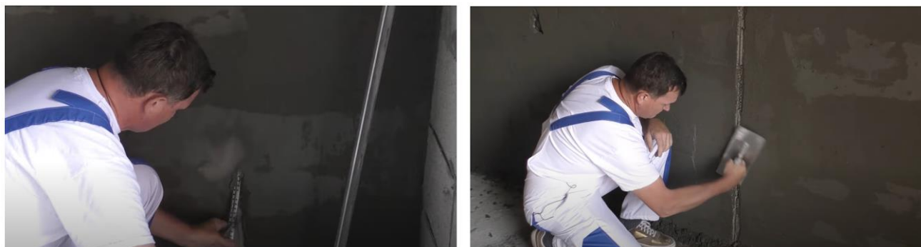
Рис. 21. Схема демонтажа маяков и заделки образовавшихся борозд
