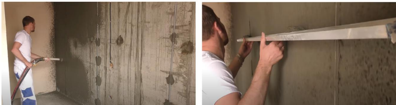
Рис. 12. Схема нанесения обрызга на поверхность и разравнивание правилами образовавшихся наплывов
