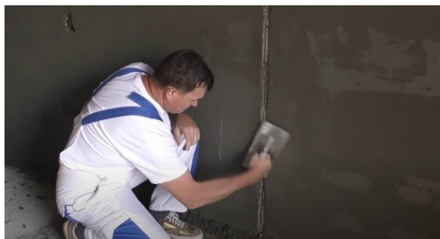
Рис. 14. Схема демонтажа маяков и заделки образовавшихся борозд
