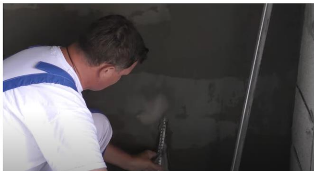
Рис. 14. Схема демонтажа маяков и заделки образовавшихся борозд
