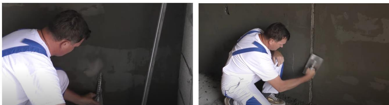
Рис. 16. Схема демонтажа маяков и заделки образовавшихся борозд
